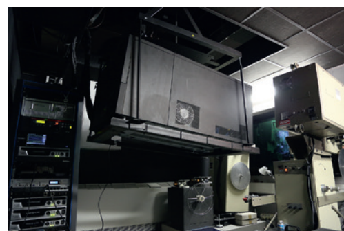
Le projecteur 4K est monté sur vérins et remonte dans le faux plafond quand une projection 35 mm est programmée
