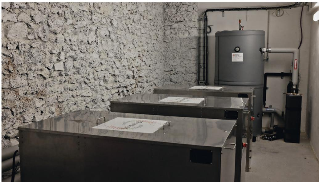
Le local de la piscine de la Butte-aux-Cailles abrite six chaudières numériques, un échangeur et un ballon de stockage. © F. Ploye
