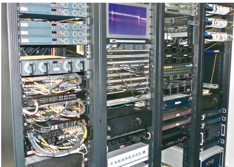
Le centre nodal avec, dans la baie de gauche, tous les équipements centraux du réseau MediorNet et des intercoms Artist de Riedel.
