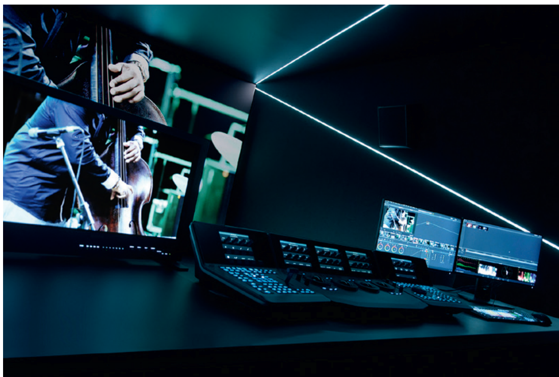
L'auditorium principal avec un projecteur 4K Sony, et surface de contrôle DaVinci Advances. © Lœdens Studio
