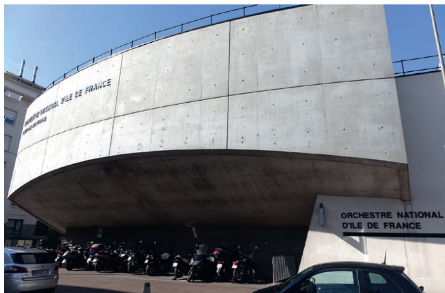
Situés à Alfortville, les locaux de l'Orchestre national D'Ile-de-France ont été entièrement mis à jour et repensés autour du nouveau studio d'enregistrement intégré.
